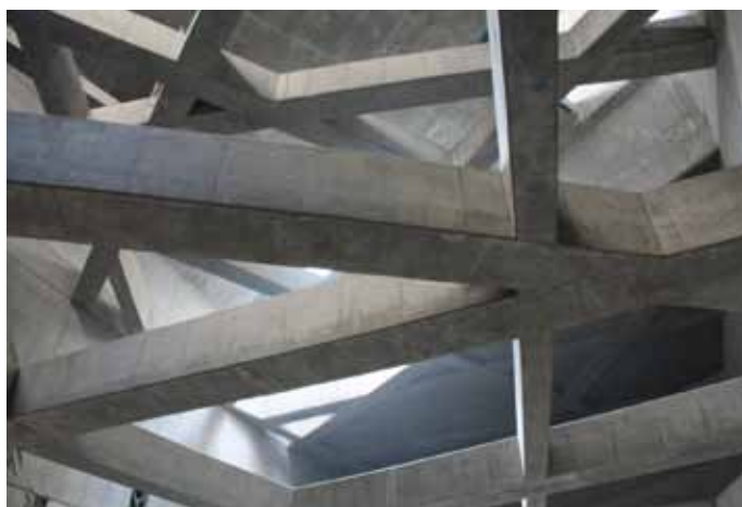
1. Budapest, M4, Fővám téri metróállomás (Az Aqua Stop Concrete Kft. archívumából, fotó: Detári Anikó)
