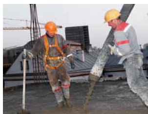
Helyszínen öntött betonszerkezetek
